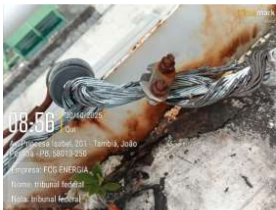
Figura 4 – Conexão do condutor de interligação do sistema de captação
