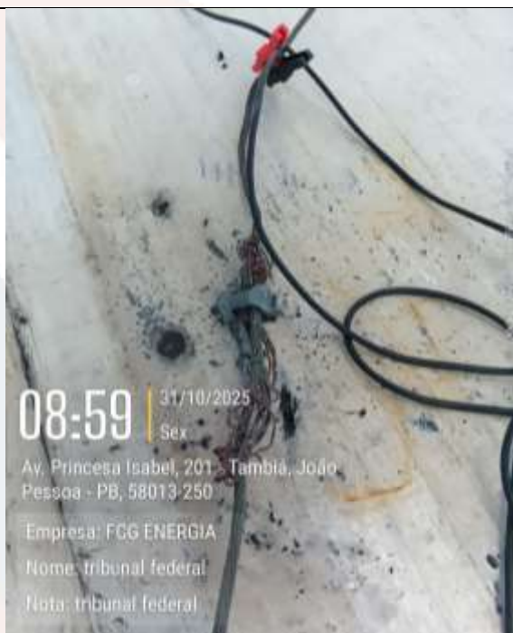
Figura 3 – Conexão do condutor de interligação do sistema de captação
