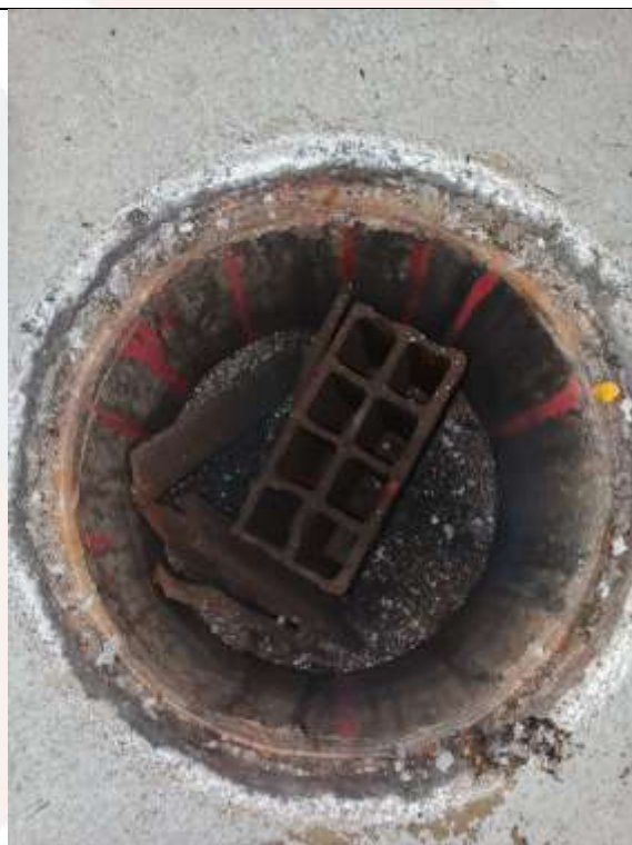
Figura 18 – Caixa de inspeção de aterramento
