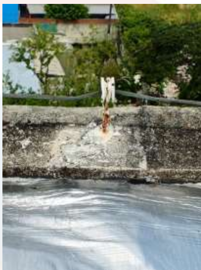
Figura 8 – Suporte de fixação de condutores
