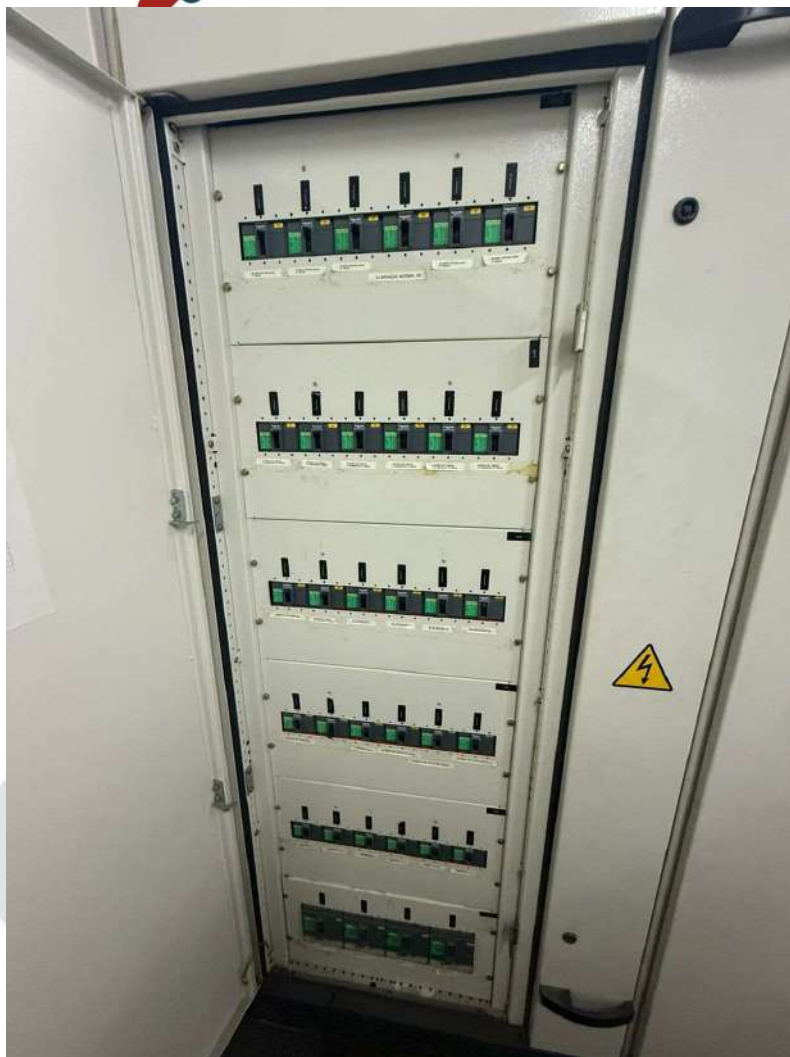
Figura 9 – Q.G.B.T sem espaço para adição de mais disjuntores.
