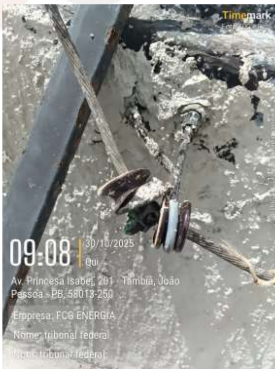
Figura 8 – Suporte de fixação de condutores
