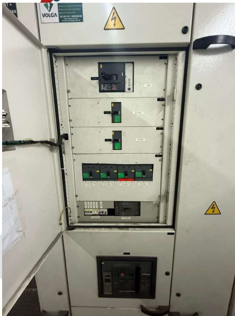
Figura 8 – Q.G.B.T sem espaço para adição de mais disjuntores.
