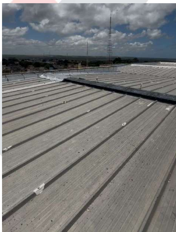
Figura 2 – Telhado da Edificação (telhas termo acústicas).
