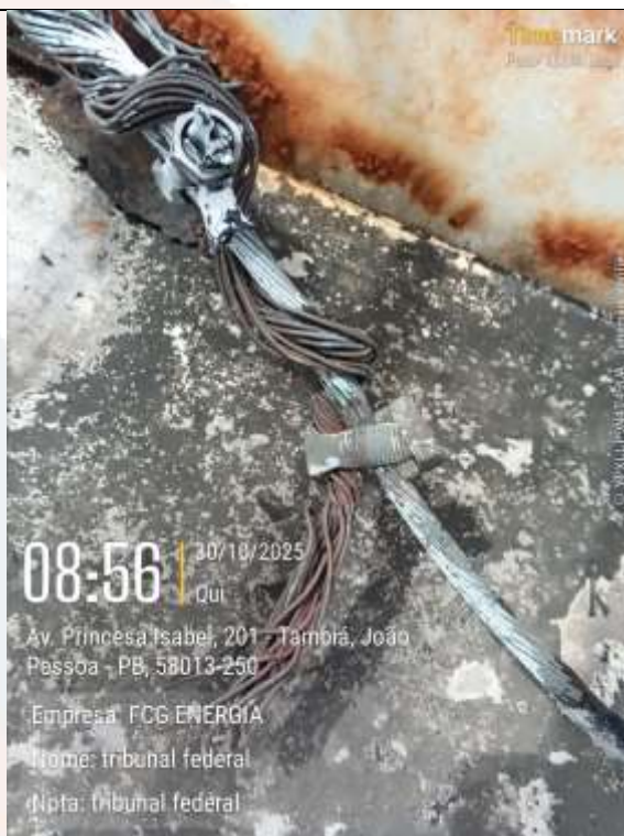
Figura 5 – Conexão do condutor de interligação do sistema de captação
