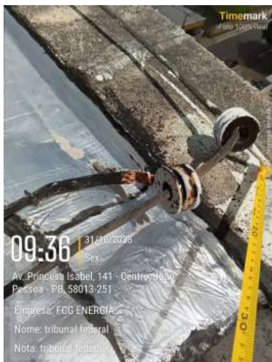
Figura 11 – Suporte de fixação dos condutores
