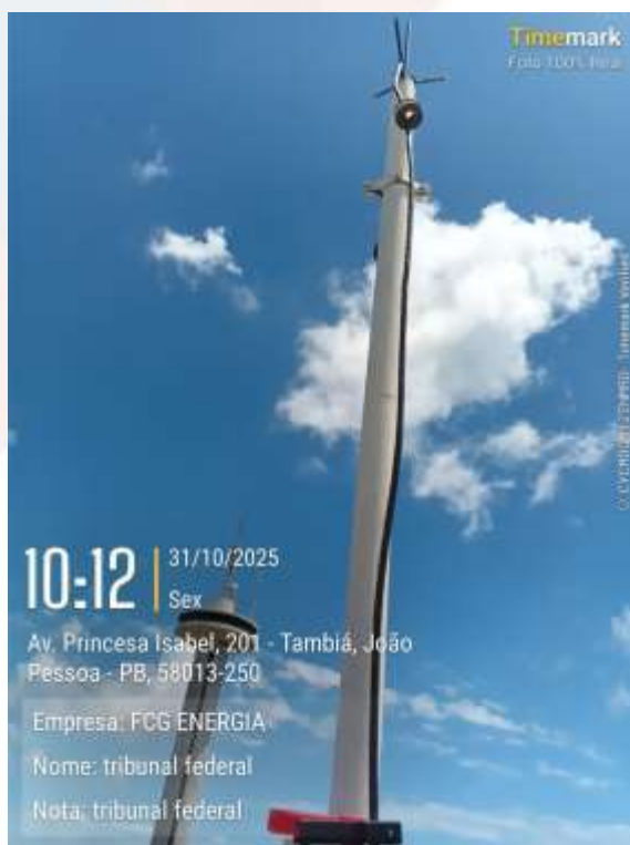
Figura 1 – Mastro de captação com condutor de cobre
