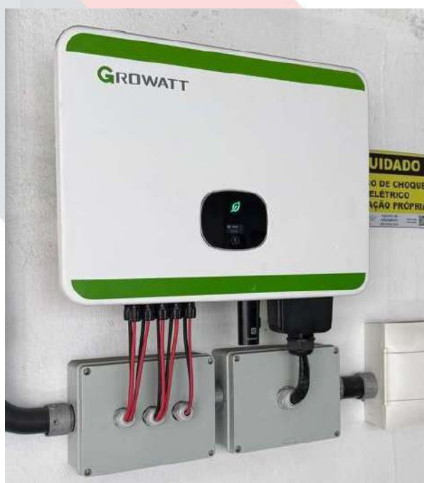
Figura 5 – Infraestrutura de instalação do inversor.
