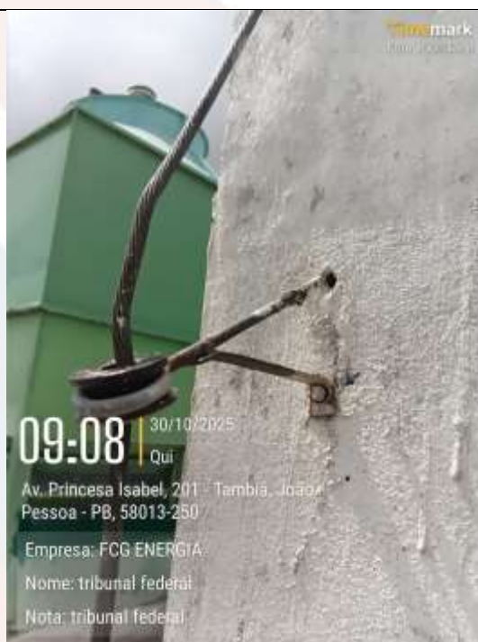
Figura 11 – Suporte de fixação dos condutores
